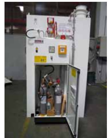
Beispielhafte automatische Löschung (Punkt 7)
